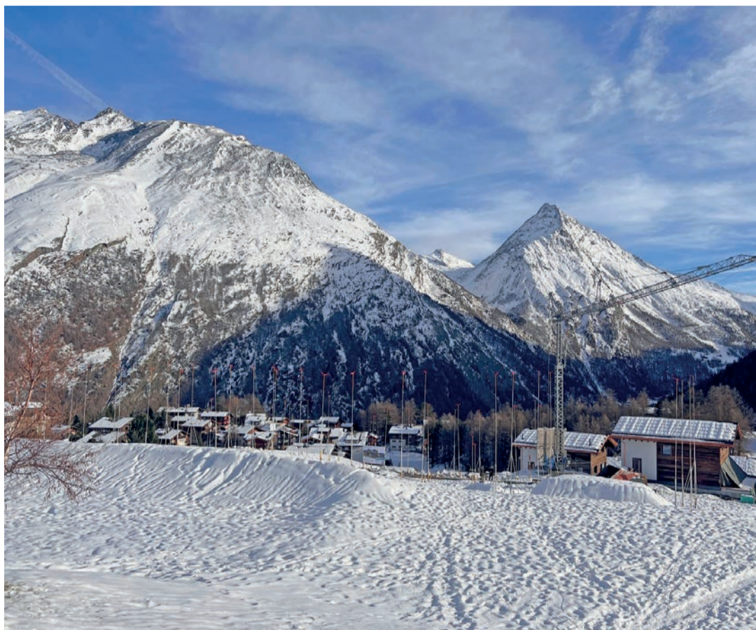
Die Bauprofile für das 40-Millionen-Franken-Projekt in Saas-Fee stehen bereits.
